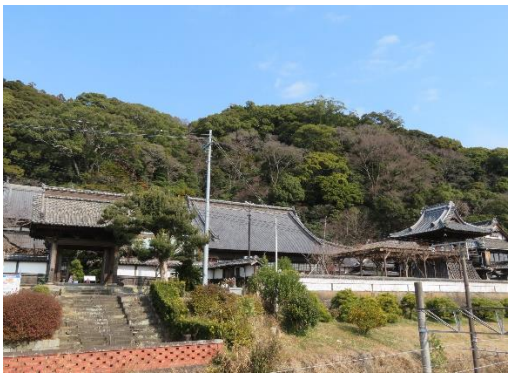
遠くから全体建物
