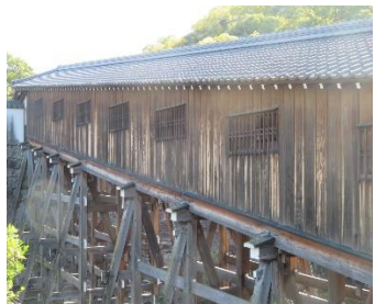
斜めにかかる御橋廊下
